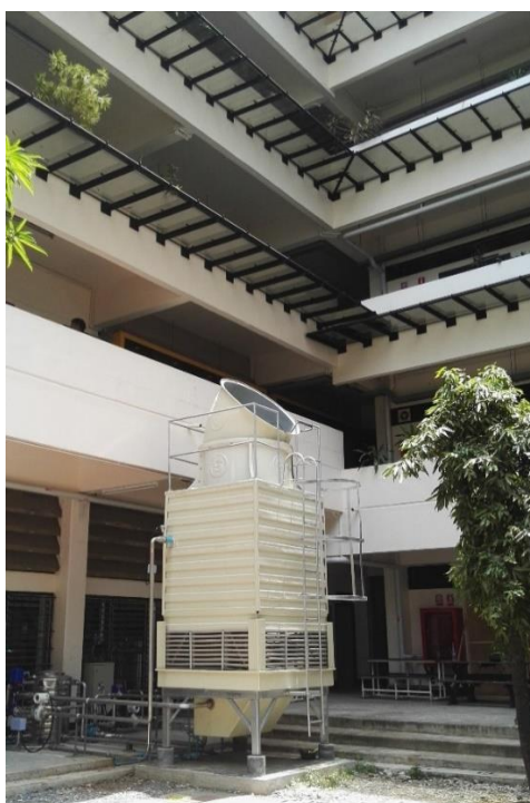
อาคารภาควิชาวิศวกรรมเคมี (อาคารที่สอง)
